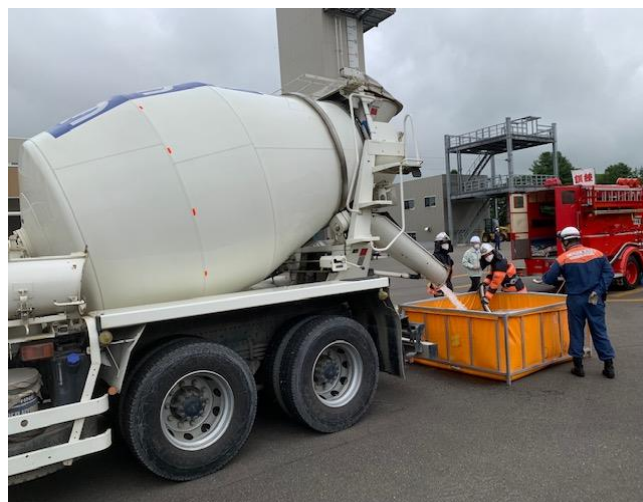
車両後方の簡易水槽へ給水訓練①
